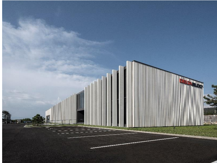
Neue DELTABLOC®-Firmenzentrale in Wöllersdorf bei Wiener Neustadt Abdruck honorarfrei bei Nennung des Urhebers: © Kirchdorfer Road & Traffic
